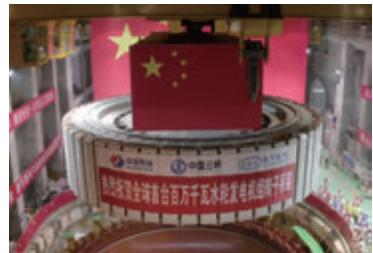
图3.1-8 白鹤滩水电站一台正在吊装的百万千瓦机组发电机转子
