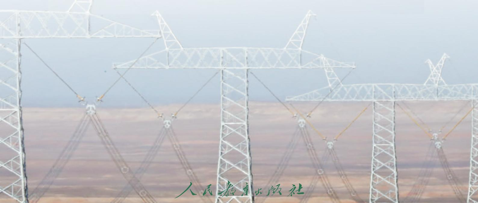
我国继三峡至常州±500 kV直流输电工程之后，又建成了宁夏至山东±660 kV和四川至上海±800 kV的直流输电工程。另外，新疆昌吉至安徽古泉新建了±1 100 kV特高压直流输电工程（图3.4-5）。这是目前世界上电压等级最高、输送容量最大、输送距离最远、技术水平最先进的特高压输电工程。直流特高压输电技术已成为我国“西电东送”战略的技术基础。
