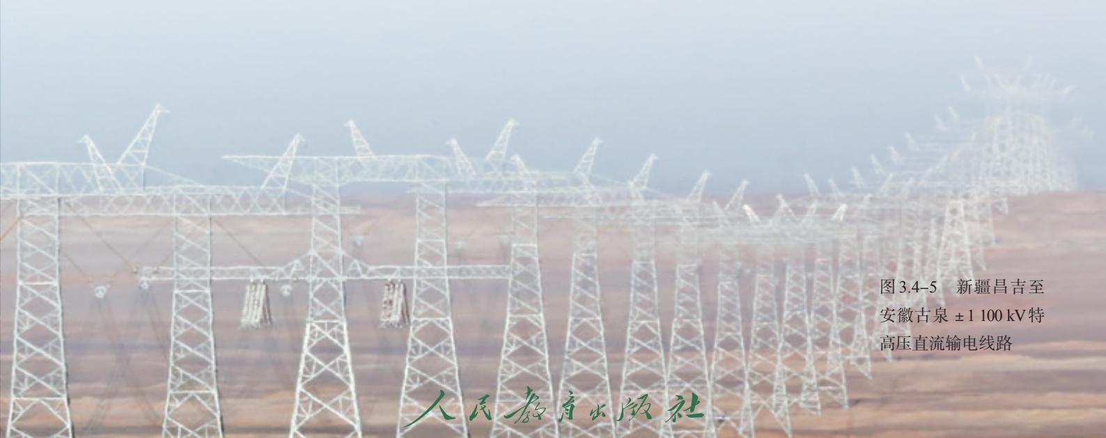
图3.4-5 新疆昌吉至安徽古泉±1 100 kV特高压直流输电线路
